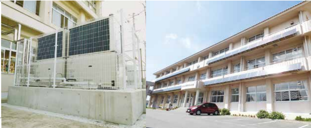
南あわじ市立松帆小学校はGHP58馬力(3台)を導入。室外機は漏水対策で堅牢な基礎工事を施した(三原中学校に設置した「バイオ」)。パーパーライザー内蔵型のため外観は通常のバルク貯槽と変わらない。
