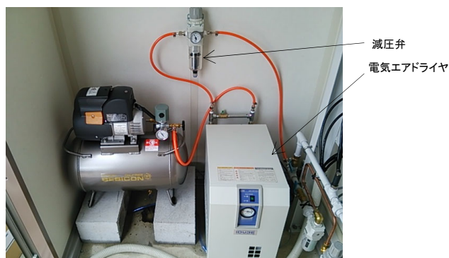
電気エアドライヤ+減圧弁
